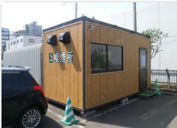
本社敷地内に設置した喫煙室
