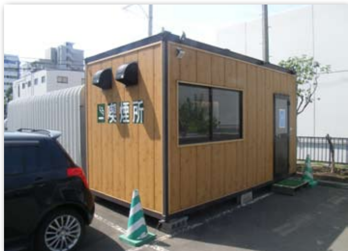
本社敷地内に設置した喫煙室
